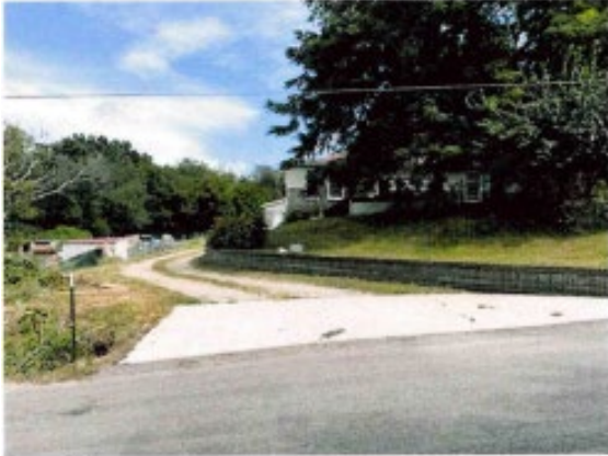
New driveway apron.
